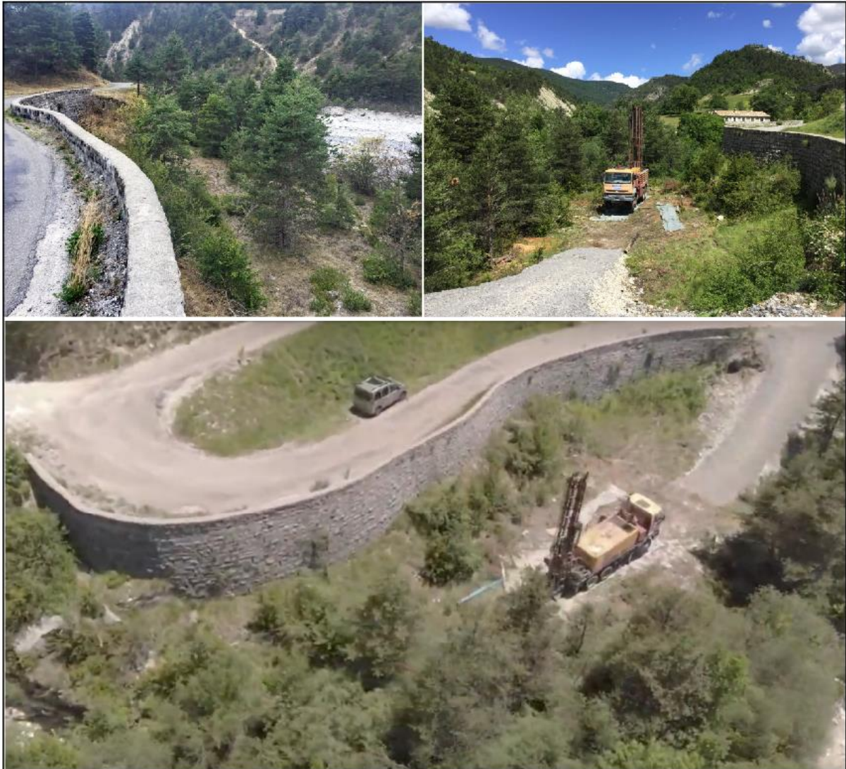
Vues sur le mur dominant le replat du PPI
